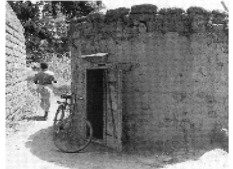
Solche Getreidespeicher der Caritas aus Lehm und Stroh helfen mit, den Hunger erst gar nicht anzusetzen.
