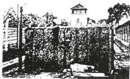
Erschließungsmauer von Gusen
